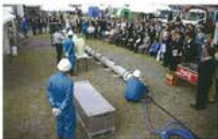
デモ施工風景
