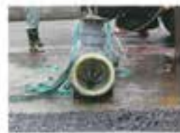
高圧洗浄試験
