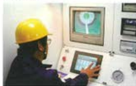
モニターカメラによる内部チェック
