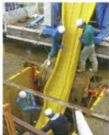
既設管への材料引込み
