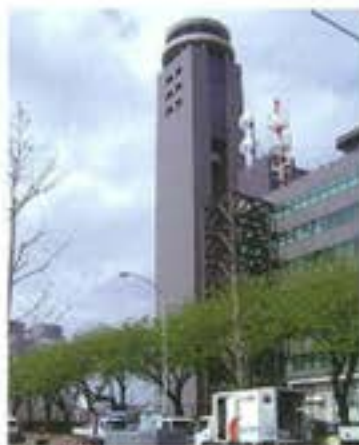
空港での施工
