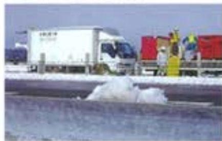
高速道路上での施工
