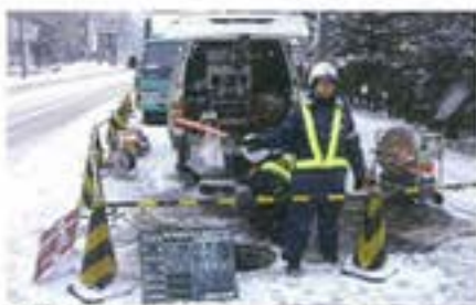
管中での施工
